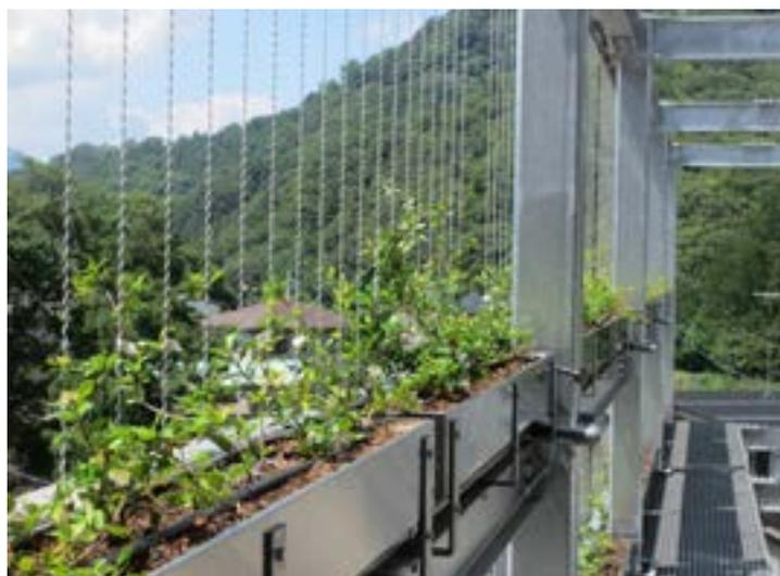
スッキリとした意匠性が特長のワイヤー式壁面緑化。吹き抜けなど空間のある場所に最適な手法です。施工が容易なため、コストの軽減にもつながるほか、スパイラル構造のワイヤーは植物が絡みやすく、樹脂被膜が蓄熱を抑え、植物の夏の熱枯れを軽減します。登坂型に対応。ワイヤーピッチは@200・300程度を標準とします。
